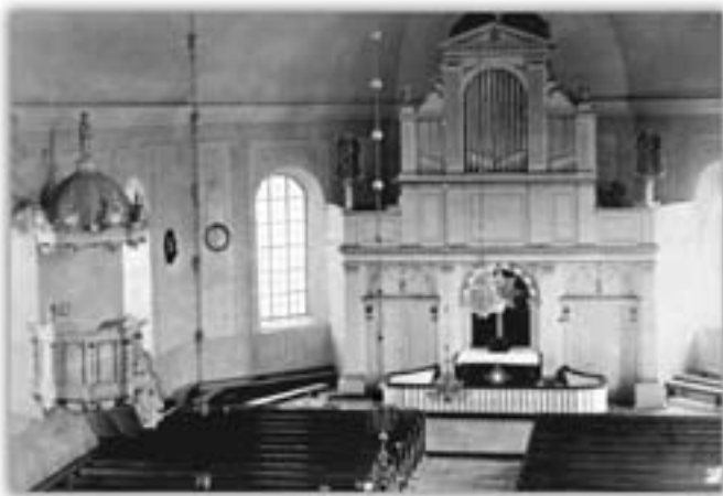
Interiörbild från Sunne kyrka före branden 1886. Foto: Frithiof Söderström Karlstad.
